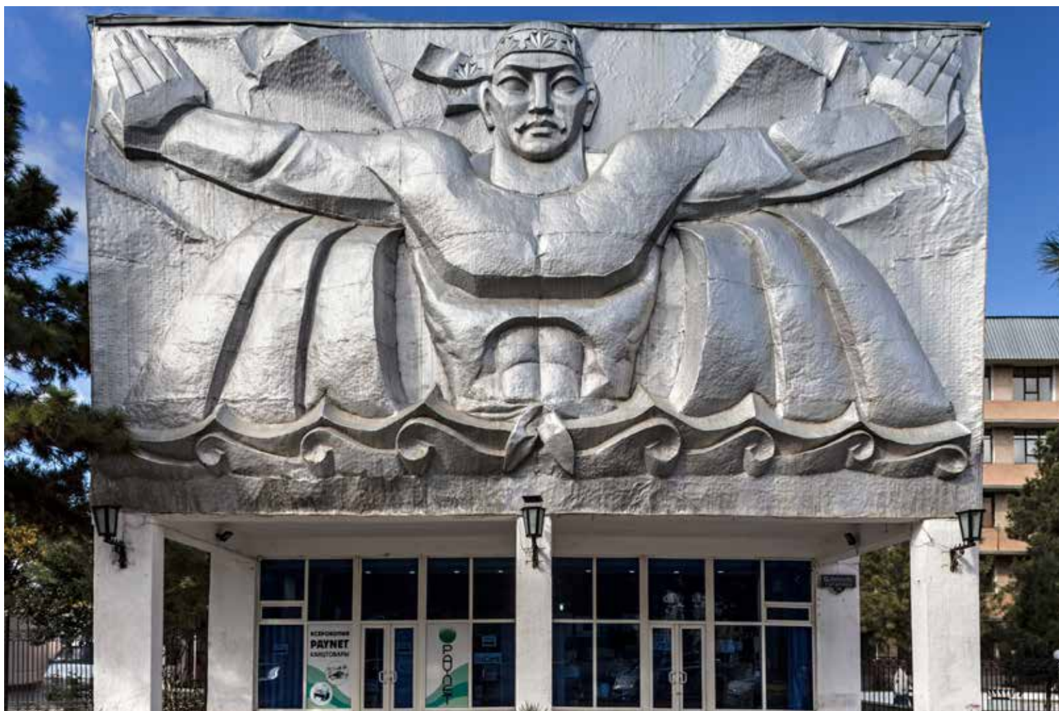
Dipartimento Gestione Acqua, 1973. Samarcanda, Uzbekistan. Photo Roberto Conte
